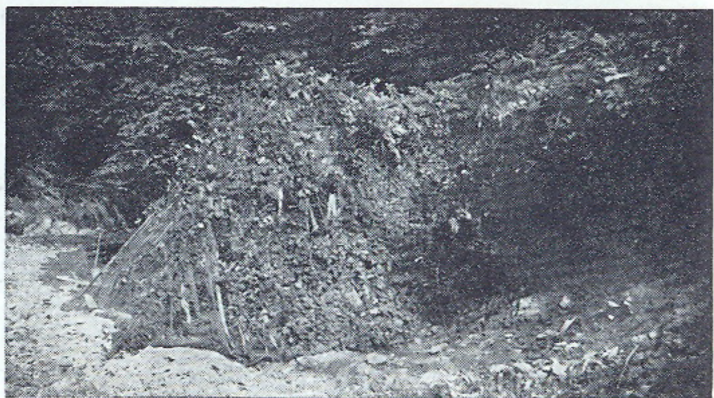
Sl. 144a Kompresorska stanica u radu — maskirana
