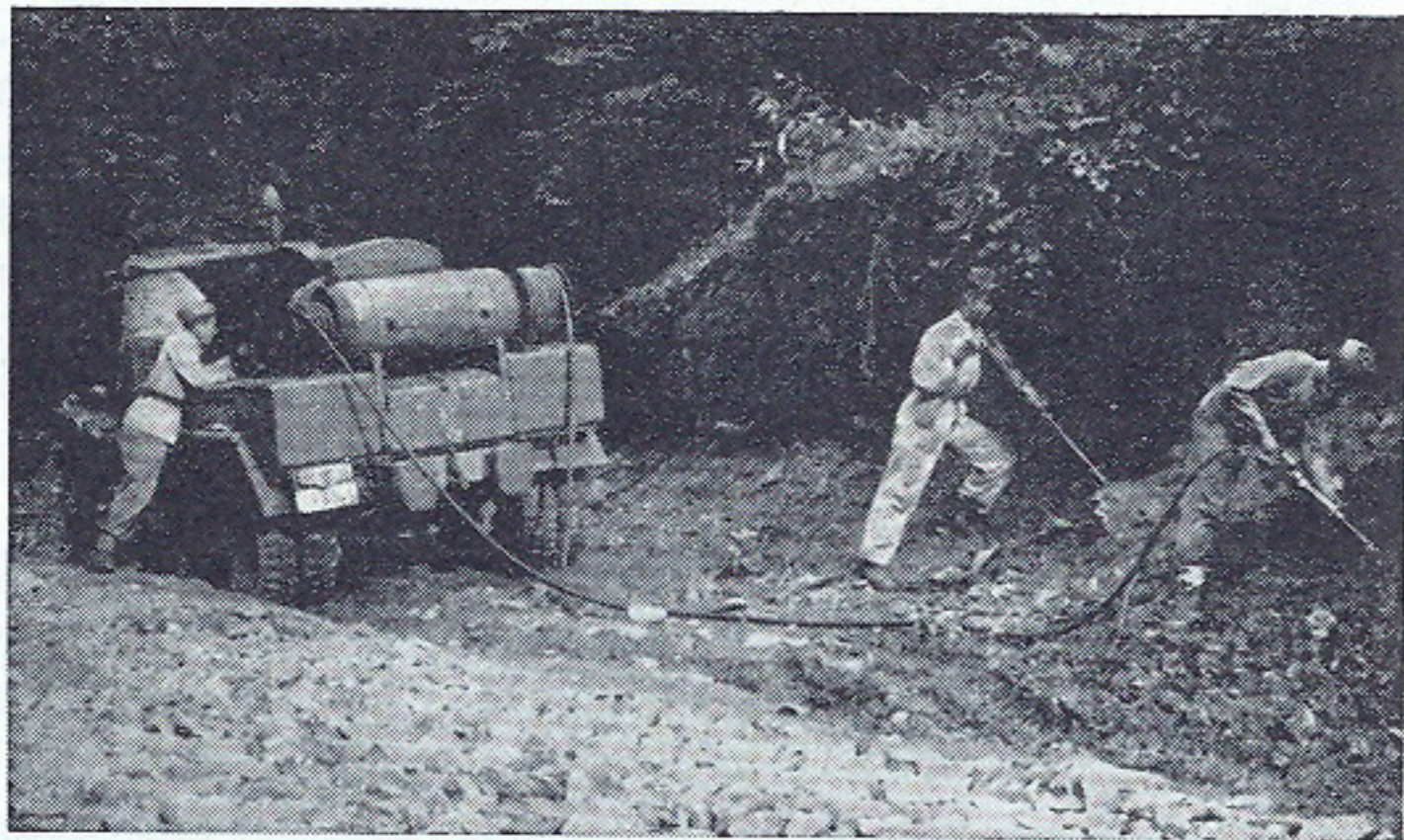
Sl. 144 Kompresorska stanica u radu — nemaskirana
