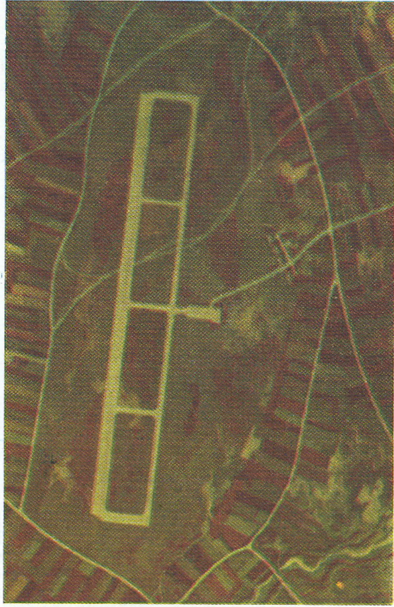
Sl. 159 Aerodrom pre maskiranja (jako uočljive betonske površine komandno-upravni objekti)
