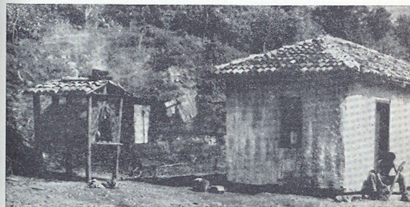
Sl. 54 Fortifikacijski objekt maskiran dekorativnim načinom u obliku seoske kuće
